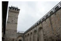
Alla scoperta della Rocca del Duce
