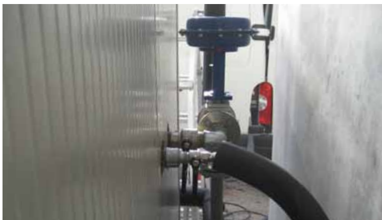
Particolare riscaldatore a pavimento.
