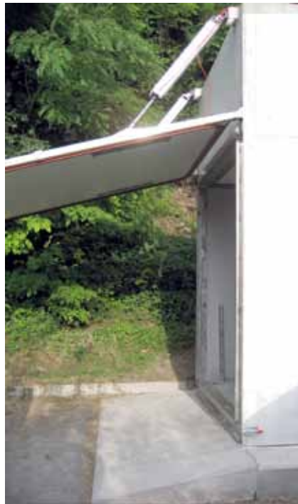
Portellone frontale con guarnizione antigas.
