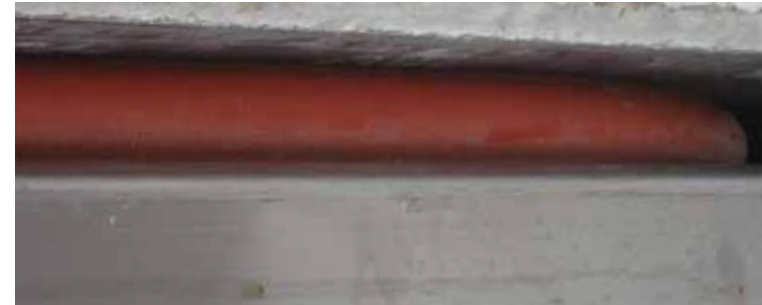
Guarnizione gonfiabile per tenuta stagna al gas.
