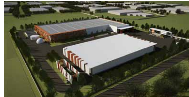
Vista aerea dell'impianto.
