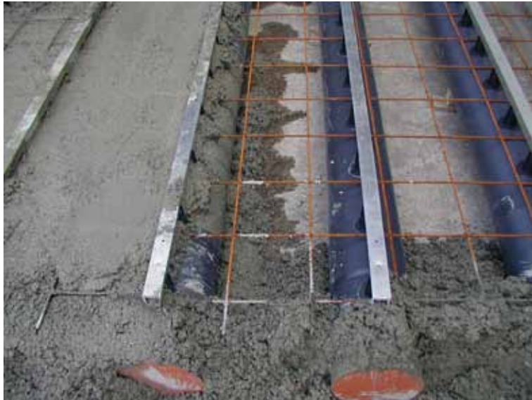
Particolare tubi aerazione a pavimento con spickets. Prima del getto in c.a.
