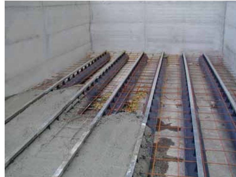
Tubi di aerazione a pavimento con spickets prima del getto in c.a.
